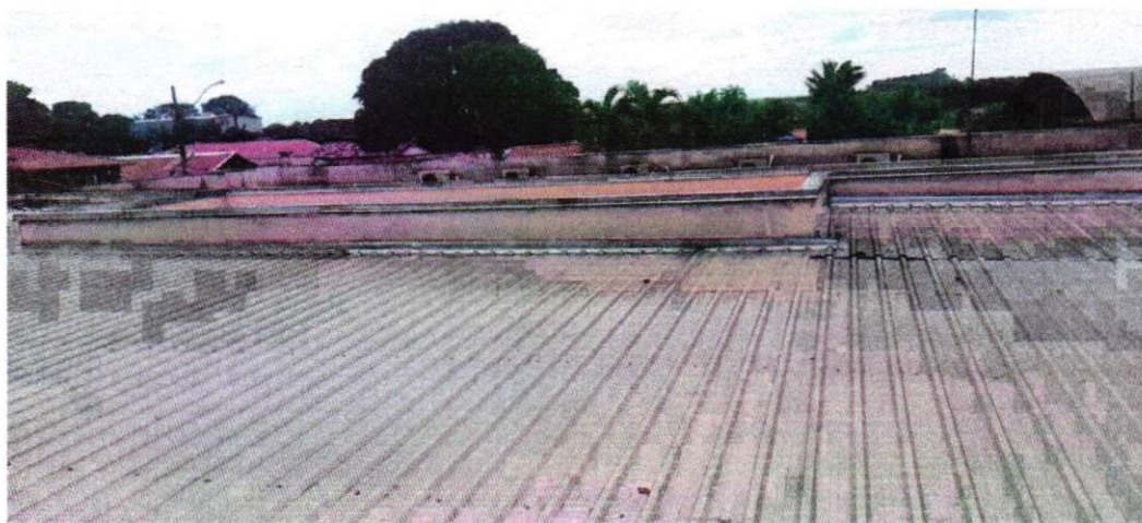
Foto 2 Análise do perímetro do telhado
