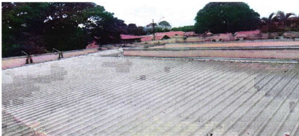
Foto 1 Análise do perímetro do telhado
