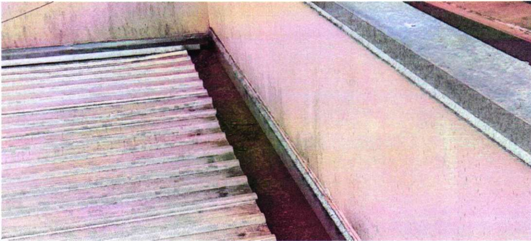
Foto 6 Análise da inclinação da calha
